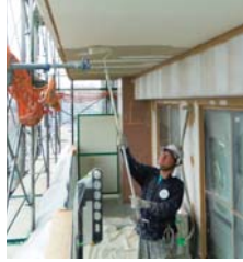
バルコニー天井・廊下天井
