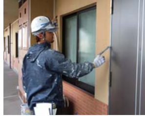
玄関ドア枠塗装
