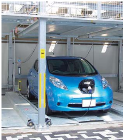
※EV充電スタンドの施工例
