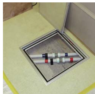
点検口開口時
