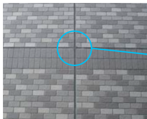
打継目地 (タイル面・塗装面)
