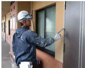
玄関ドア枠塗装
