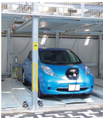
※EV充電スタンドの施工例
