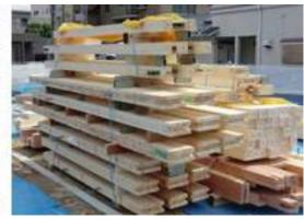
事前に外部足場を組み立ててから行っていきます。 材料は事前に工場で加工済(プレカット)の材料なので組上がりは非常にスピーディーです。
