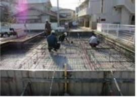
▲コンクリートスラブの打設 ▲基礎立上りコンクリート打設 立上り型枠にコンクリートを流し込み 床下全面にコンクリートを打設します。 ます。
