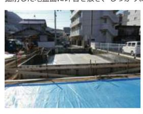
▲型枠工事 基礎外部に型枠を設置します。
