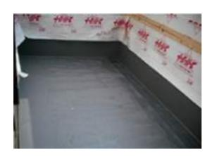
▲バルコニー防水工事 雨水の侵入を防ぐため防水工事を行います。水漏れに対して、10年間の保証がつきます。
