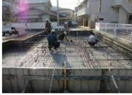
▲基礎配筋 設計図に従ってコンクリートの中の鉄筋を配置します。 コンクリート打設前に配筋検査を行います。
