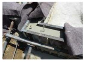
▲レベラー施工 基礎の天端の水平精度を上げるためレベ ラーの作業を行います。急速な乾燥割れ を防ぐため、養生も行います。
