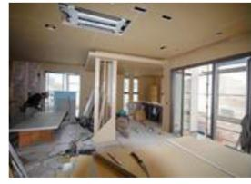
▲木工事(石膏ボード張り) 石膏ボードとは、壁や天井に使用される室内の下地材料です。 外部に面する部分に断熱材を入れます。 この上からクロス (壁紙)を張り付けて仕上げていきます。
