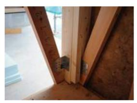
▲金物工事 柱と筋かいを専用の金物を使って強固に 固定します。
