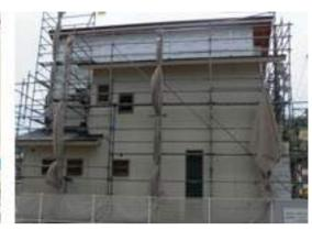
▲外壁工事 耐力面材の上に透湿防水シートを張り付けます。透湿防水シートとサイディング材との間に空気層を設け、通風をよくします。
