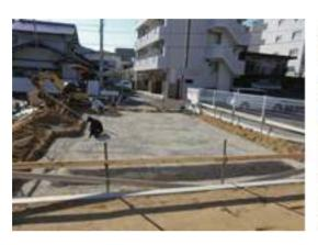
▲地業工事 基礎をつくる前の下地準備をします。 掘削した地盤面に砕石を敷き、しっかり締め固めます。
